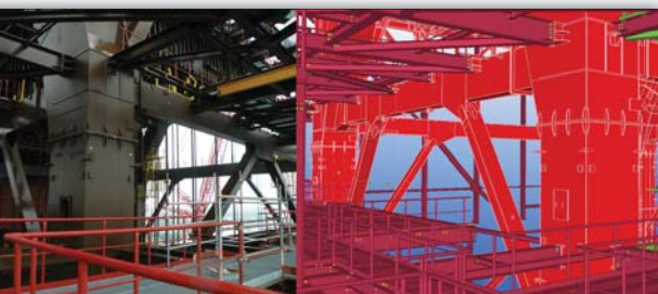
Rys. 1 Słupy ramy konstrukcji wsporczej kotła – widok podczas realizacji oraz w programie Tekla Structures [źródło: Biuro Inżynierskie Jakosta]
